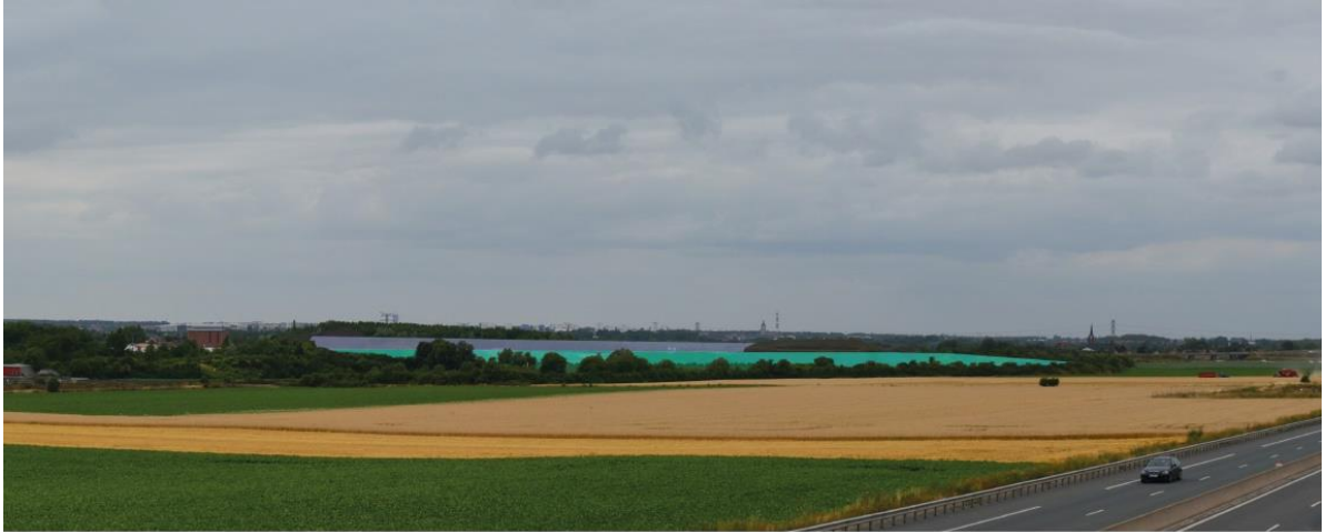
Vue du site depuis la Nationale 17, côté Est – Source : Étude d'impact du projet GAZONOR
