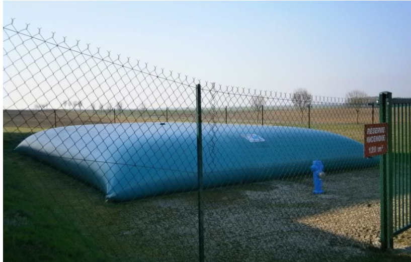
Exemple de citerne souple d'eau destinée aux pompiers – Source : Gazonor
