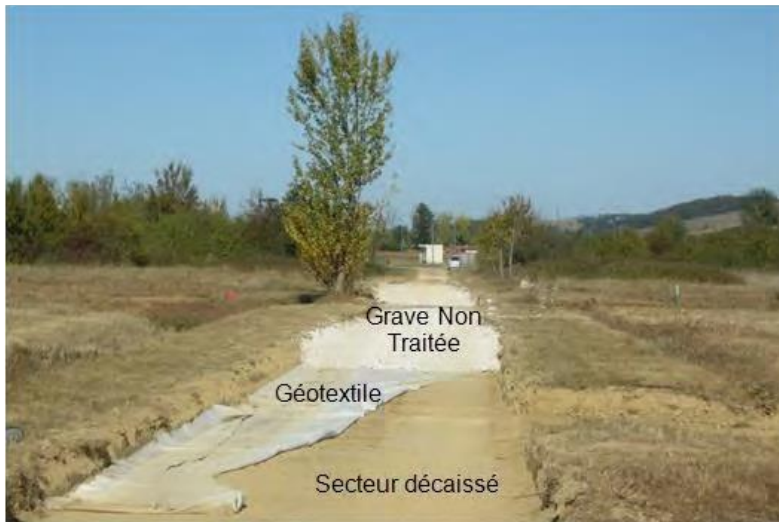
Mise en place d'une voie engins – Source : Gazonor
