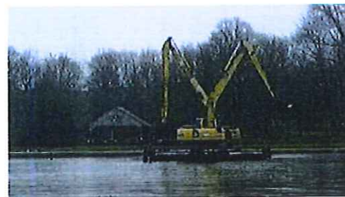
Curage des plans d'eau Parc de la Glissoire
